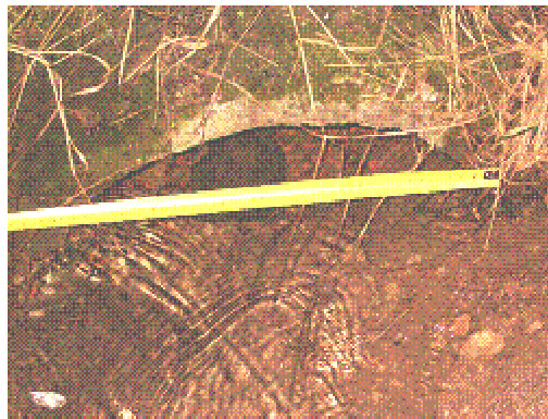
Joonis 3.8. Aleviku lääneosa sademevee kanalisatsiooni väljalasu asukoht (vasakul) ja pooleldi setetega mattunud toruots (paremal)
