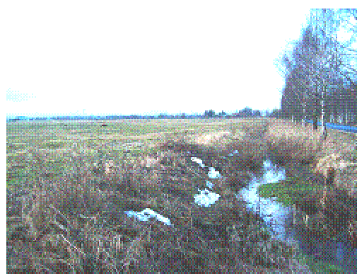
Joonis 3.5. Ussimäe küla kinnikasvanud kraavide süsteem (vasakul), mis juhib liigvee Näpi ojja (paremal)
