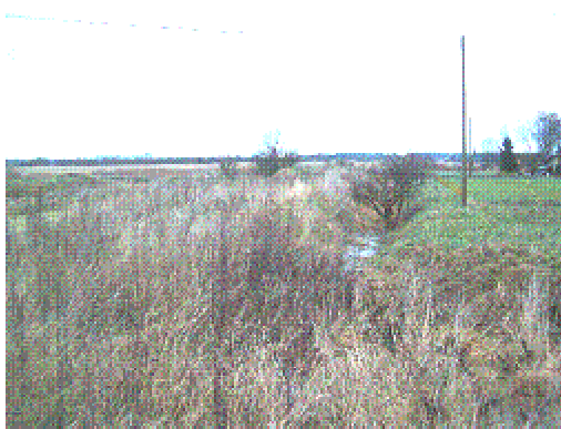
Joonis 3.5. Ussimäe küla kinnikasvanud kraavide süsteem (vasakul), mis juhib liigvee Näpi ojja (paremal)
